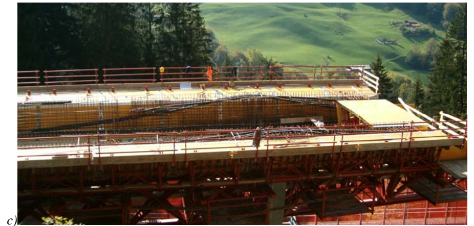
Figure 1.12 : Câbles paraboliques pour une (a) poutre simple et (b) une poutre continue ; (c) exemple de câbles de précontrainte dans un pont continu sur plusieurs travées
